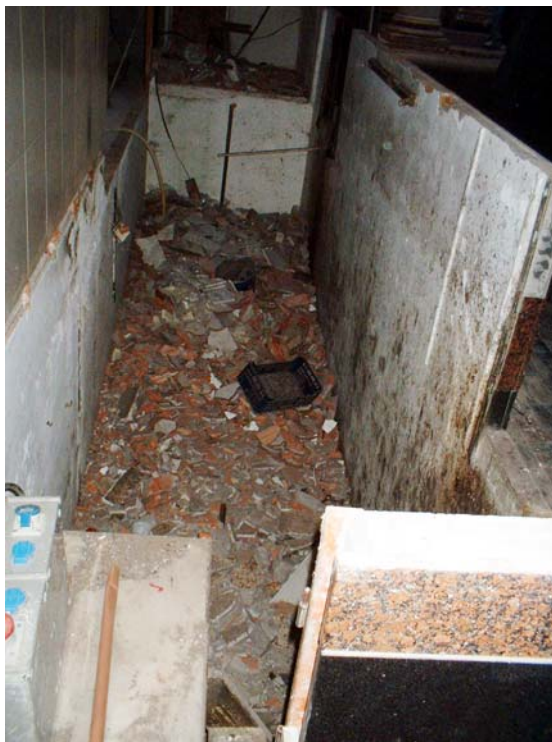
Fotografia 3: Vista de la parada 253-257 del Mercat de la Boqueria, on s'observa el 1'5 m de desnivell respecte del nivell de circulació actual.
