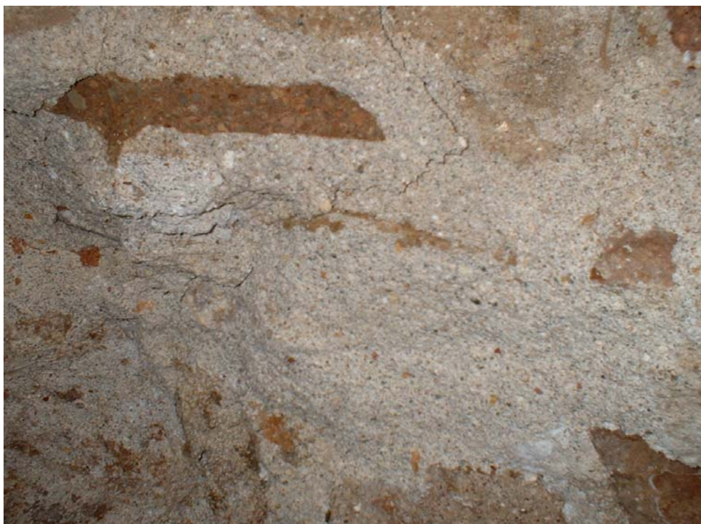
Fotografia 10: Detall del morter utilitzat per la construcció del murs.
