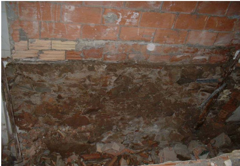
Fotografia 7: Paret posterior de maons de la parada 248-249 damunt el mur U.E. 203 que li serveix de sustentació.
